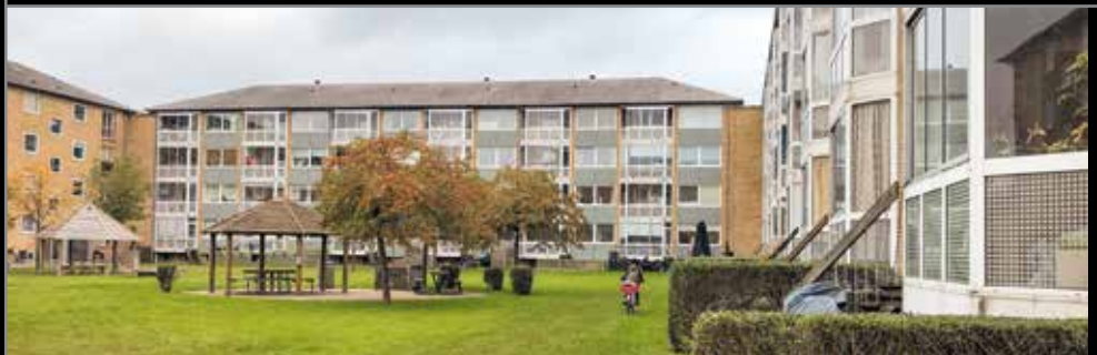
I det særligt udsatte boligområde på Motalavej i Korsør lider beboerne under familiefejder mellem to libanesiske klaner. Nu vil regeringen gøre det nemmere at sætte kriminelle familier ud af deres lejligheder.
